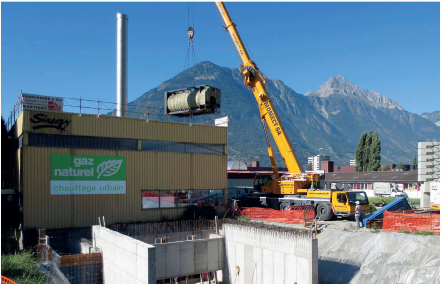
Der Bau der Anlage in Martigny
