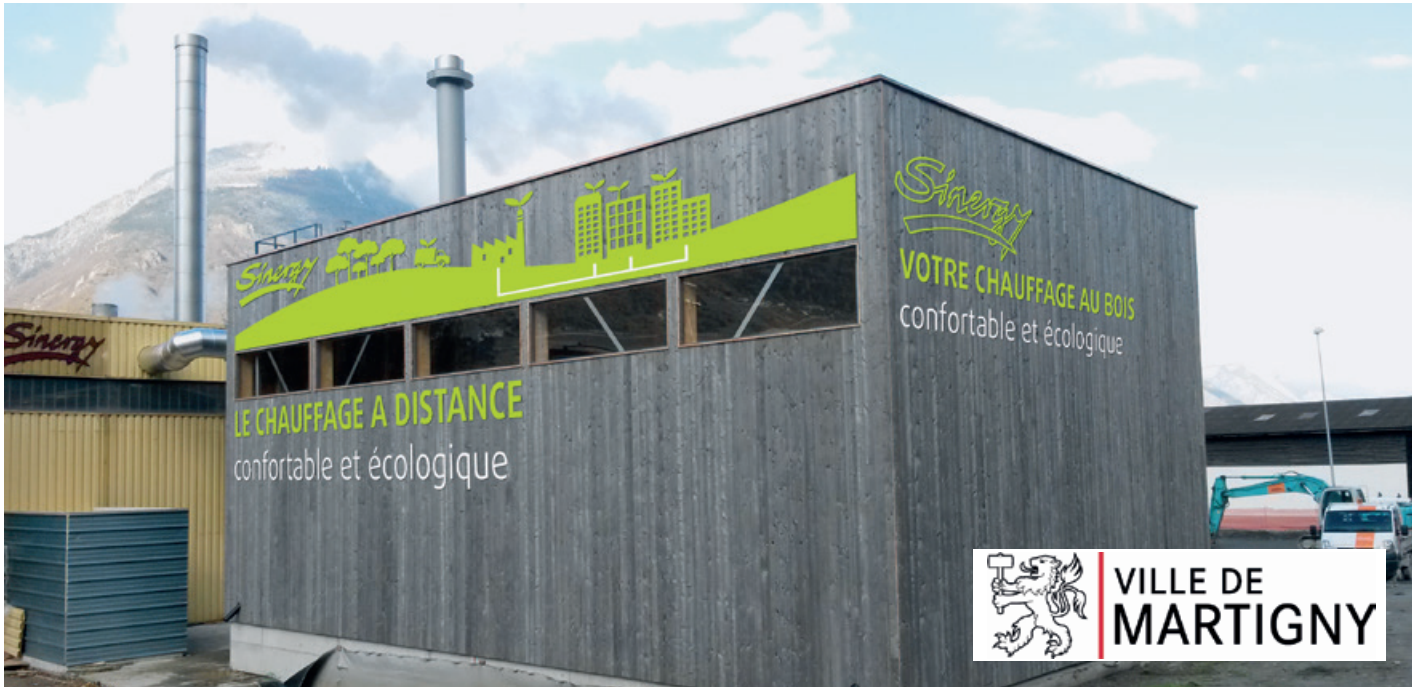
Die Holzverbrennungsanlage in Martigny
